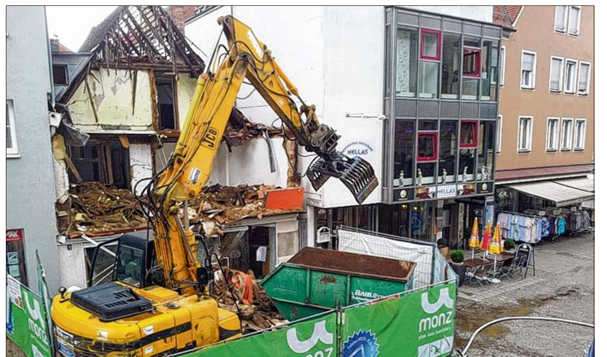
Die südliche Hauptstraße ist mit dem Gebäudeabriss um eine Baustelle reicher.
