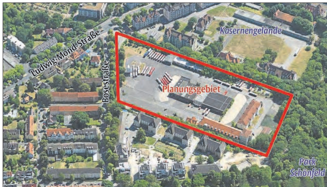
Zwischen Auestadion und Park Schönfeld entsteht ein neues Wohnquartier: Der Bauräger Innovation will ab 2016 das Kernstück des Jägerkasernengeländes bebauen. Die Spitze am unteren Bildrand ist nahezu voll mit neuen Wohnungen. Repro: HNA / Planung und Geoinformation Stadt Kassel
