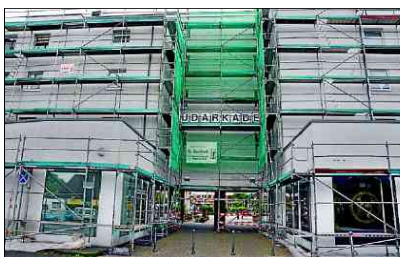
Während der Sanierung sind die Südarkaden eingerüstet. FOTO: ARNDT
